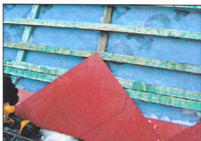
popis 1 Montáž přídatné latě pro připevnění stoupací plošiny
