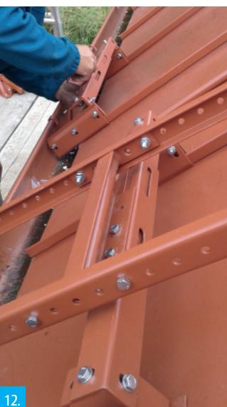
11. Usazení žebříku do držáku. Při nasazování si žebřík natočíme stranou a nosič příčky protáhneme mezi bočnicemi a dorazíme příčku do profilu nosiče. pokud to jde obtížné, můžete si povolit šrouby držící příčku žebříku a tím mírně roztahnout bočnice od sebe. Nezapomeňte poté šrouby opět dotáhnout!
