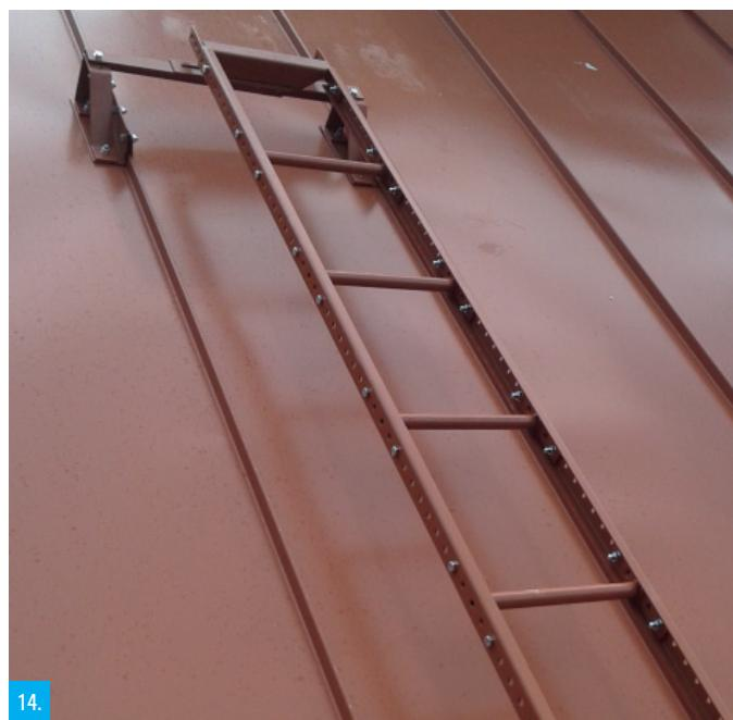
14. Pohled na namontovaný jeden střešní žebřík, který bude dále nastavován směrem nahor. Tímto způsobem montujeme střešní žebřík i na jiné druhy nefalcovaných krytin (jako jsou plechové ve tvaru tašek, pálené i betonové, vláknocementové i bitumenové, s použitím příslušných uni šablon nebo mezivln a ploten PLATON).
