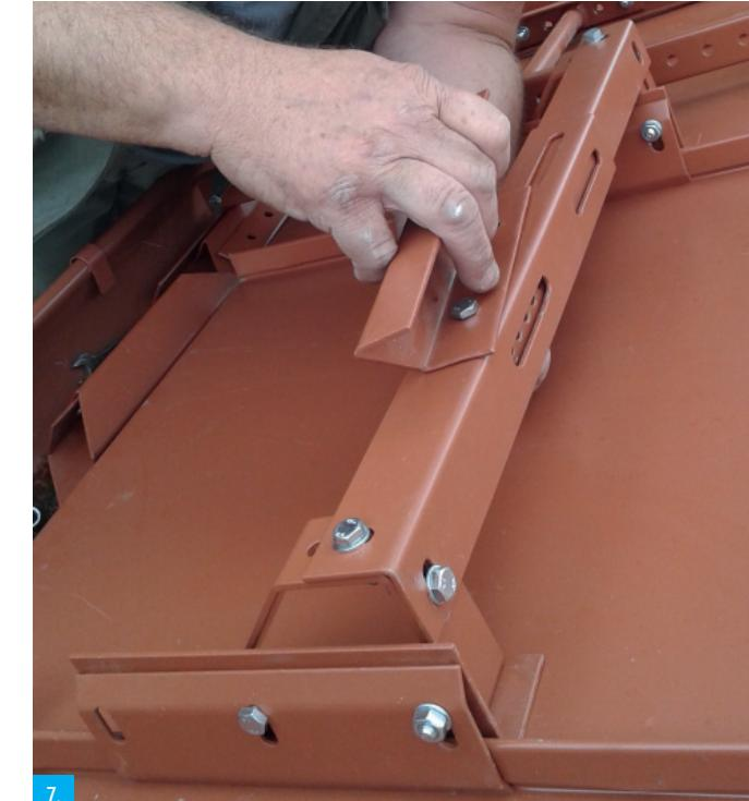
Oba konce hrazené si nasadíme na sousední falcov v potřebné poloze a ve střední části je sestavíme a zkompletujeme s nosičem příčky žebříku a upravíme dle rozteče falců.
