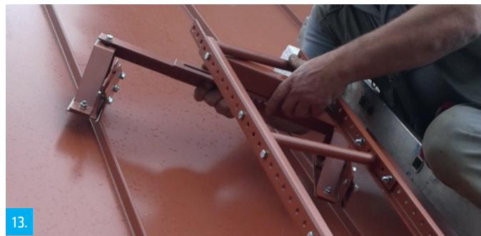
Obdobným způsobem namontujeme již smontovanou hrazdu s nosičem a držáky, jen s tím rozdílem, že nenatáčíme žebřík, ale smontovanou hrazdu. Usadíme na falty a dostatečně dotáhneme šroubové spoje, opět zejména na držácích č. 132. Dotáhneme je tak, až se příložník mírně prohne, v žádném případě nedotahujeme až na maximální prohnutí příložníku.
