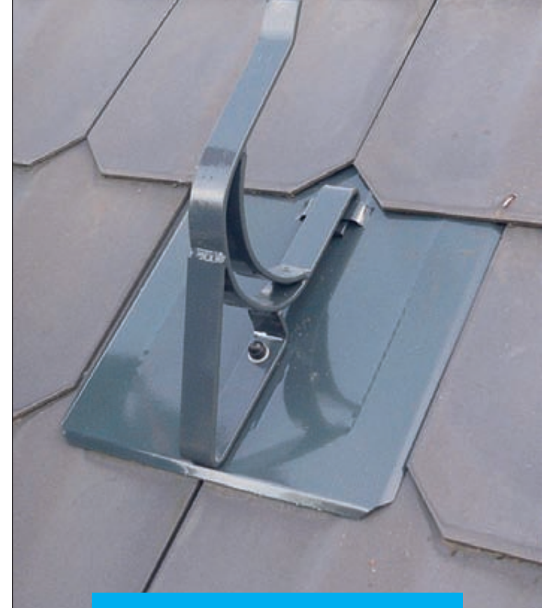
11. Pohled na kompletní nainstalovaný obdélník s držákem kulatiny a krytkou hlavy šroubu na centrálním vrutu.
