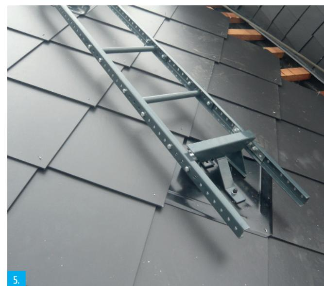
5. Ostatní zbývající příčky rozmístíme rovnomořně mezi již použité a případně ještě možno příčku použít na koncích žebříku, pokud nám díky formátu krytiny vznikne takový přesah bočnic žebříku jako na obrázku.
