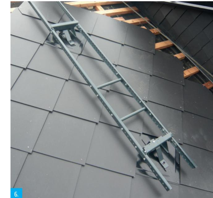
6. Vzdálenost příček od sebe by neměla překročit 32 cm. Pokud používáme jen jeden žebřík bez spojování s dalším žebříkem, neměly by přečnívající konce žebříku (po příčku) být delší než 25 cm.
