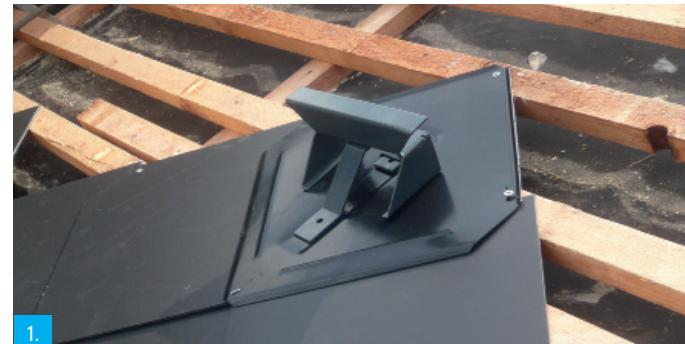
1. Střešní žebřík se do maloplošné hladké krytiny připevňuje pomocí držáku č. 164, který sestává ze dvou kusů. Je nasazen do základní kovové šablony pro příslušný typ/materiál a tvar krytiny. Držák v jiném provedení se dodává i pro profilované krytiny.
